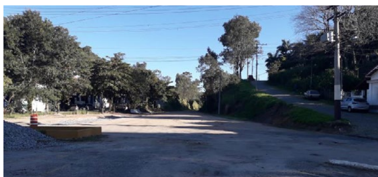
Figura 4- Linha férrea aterrada para tráfego de veículos no entorno da estação ferroviária de Governador Portela.
